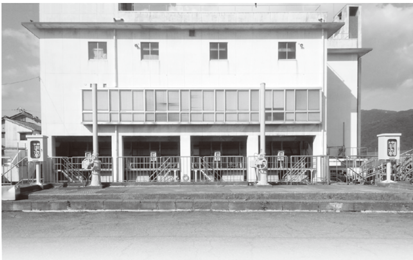
[写真：松島のポンプ場]
